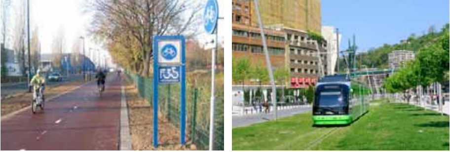
Radschnellwege und leise Niederflurstraßenbahnen auf Rasengleisbett: Ein Plus an Lebensqualität
