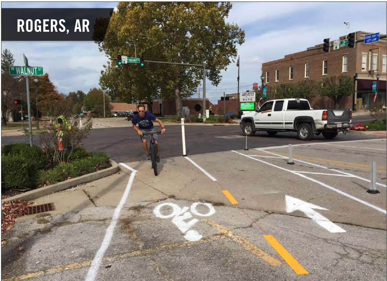
Leicht und schnell angelegte »bike lane« mit Sprühfarbe und Absperrbaken *
