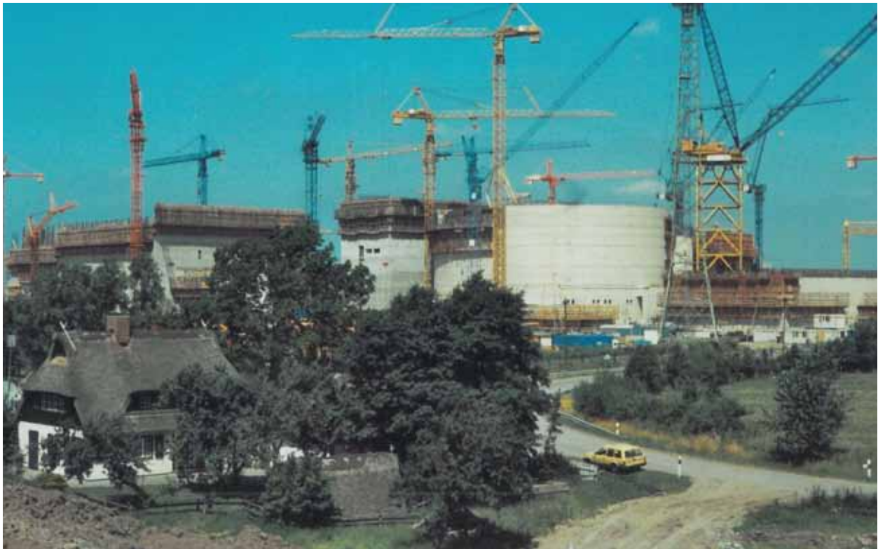
Juli 1986 Das AKW Brokdorf ist nach drei Jahren Gerichtsstopp im Bau.
